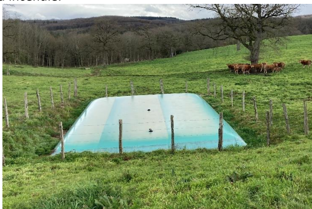
Figure 41 : réserve à incendie présente sur site
