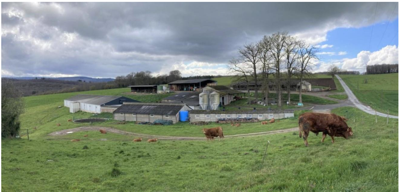
Photo 1 : Vue prise à l'ouest en limite du lieu-dit Frais Marais, avec de gauche à droite, le bâtiment de 2012, l'engraissement, le bâtiment comprenant le local machine à soupe et salle d'attente
