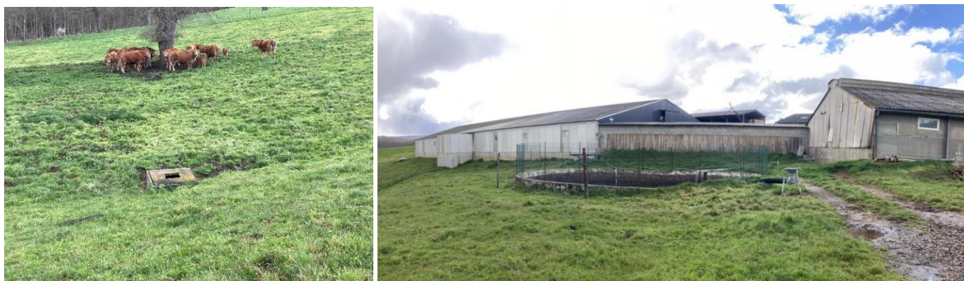
Figure 10 : fosse extérieure de stockage et regard de contrôle collectant les drains autour de la fosse
