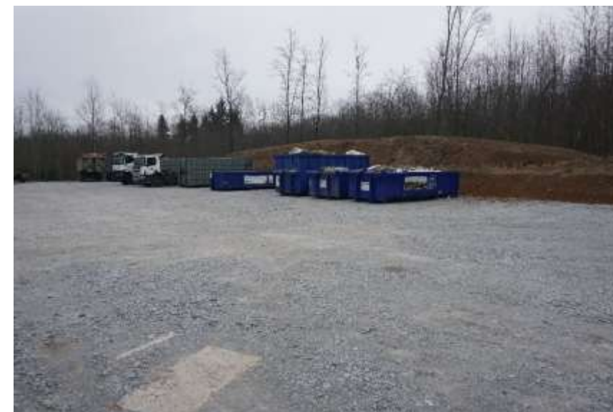
Zone de stockage et dépôts de terre
