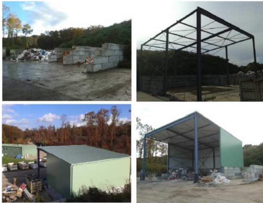
Figure 21 : Photographies du bâtiment de tri.
