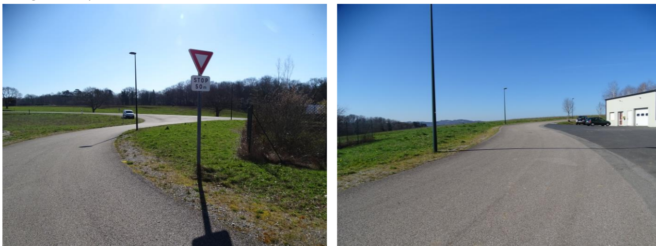
Figure 138 : Vue depuis le chemin de la ZAE de la Croix Lattée. A gauche : vue sur la RD 15. A droite : vue sur la ZAE la Croix Lattée
