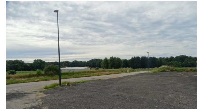
Figure 141 : Eclairage public de la zone d'activités économiques de la Croix Lattée
