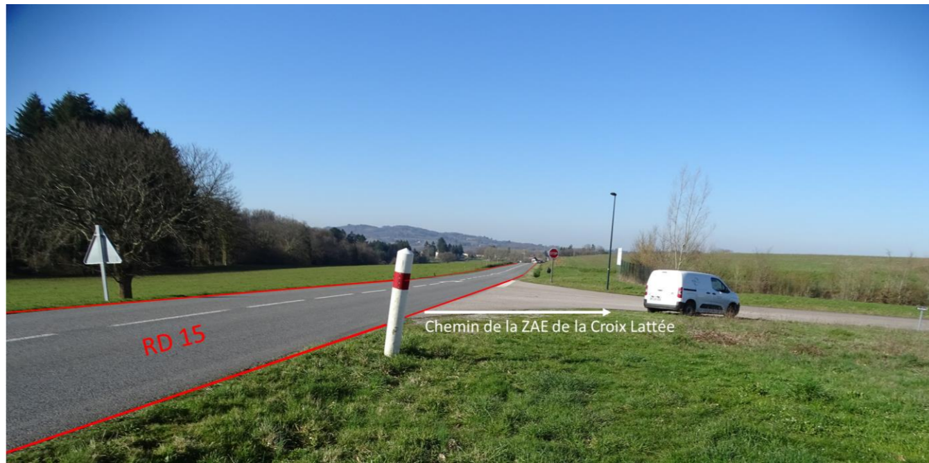
Figure 137 : Carrefour entre la RD 15 et le chemin de la ZAE de la Croix Lattée
