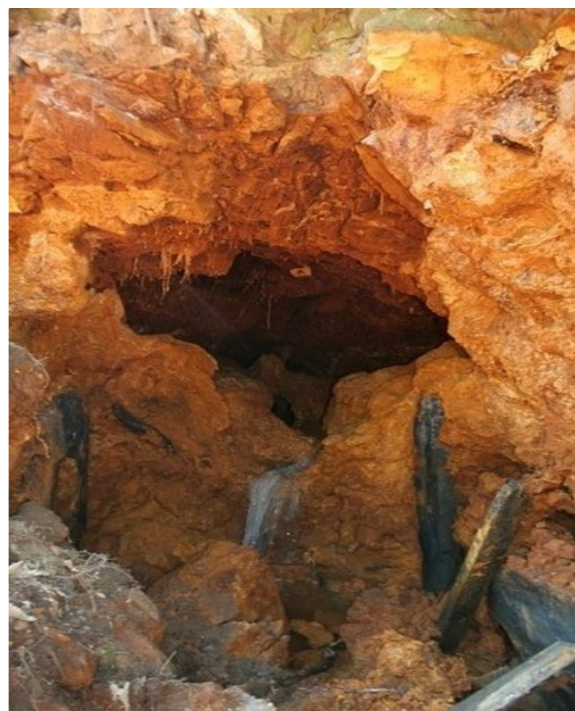
Figure 5 : Entrée de la galerie du Repaire avant travaux en 2009.
