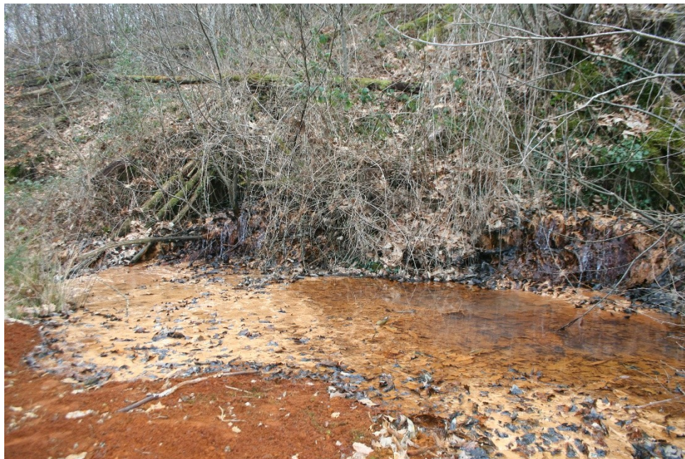
Figure 4 : entrée de la galerie du Repaire obstruée par des blocs et la végétation avant travaux en 2009
