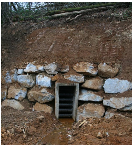
Figure 8 : Galerie après travaux (décembre 2009)
