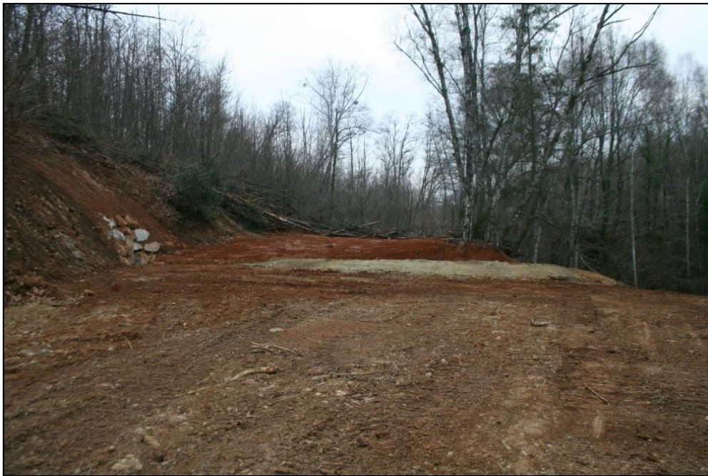
Figure 13 : Vue globale du site de la galerie du repaire après travaux
