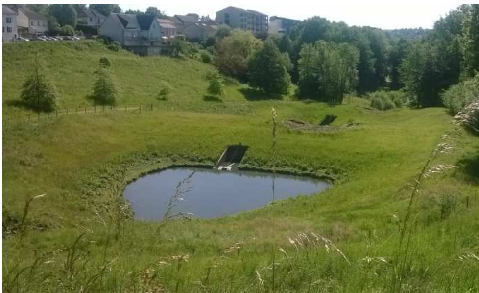
FIGURE 46 : PHOTOGRAPHIE DES BASSINS DE RETENTION EN CASCADE DEPUIS L'AMONT
