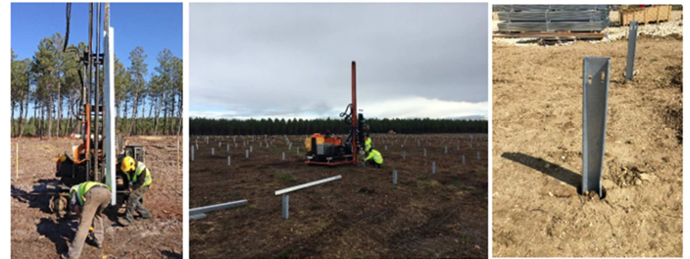
Exemples de mise en place des pieux sur les chantiers URBASOLAR
