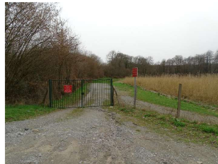
Station de traitement des eaux usées de Chaptelat
