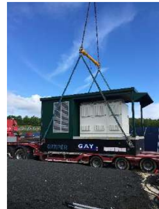
Exemple de livraison d'un poste électrique (source : Urbasolar)
