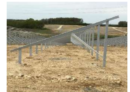
Exemple d'une structure porteuse complète avant mise en place des panneaux
