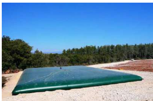
Exemple de citerne incendie (source : Urbasolar)
