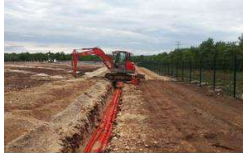
Exemple d'enfouissement de câbles électriques (source : Urbasolar)
