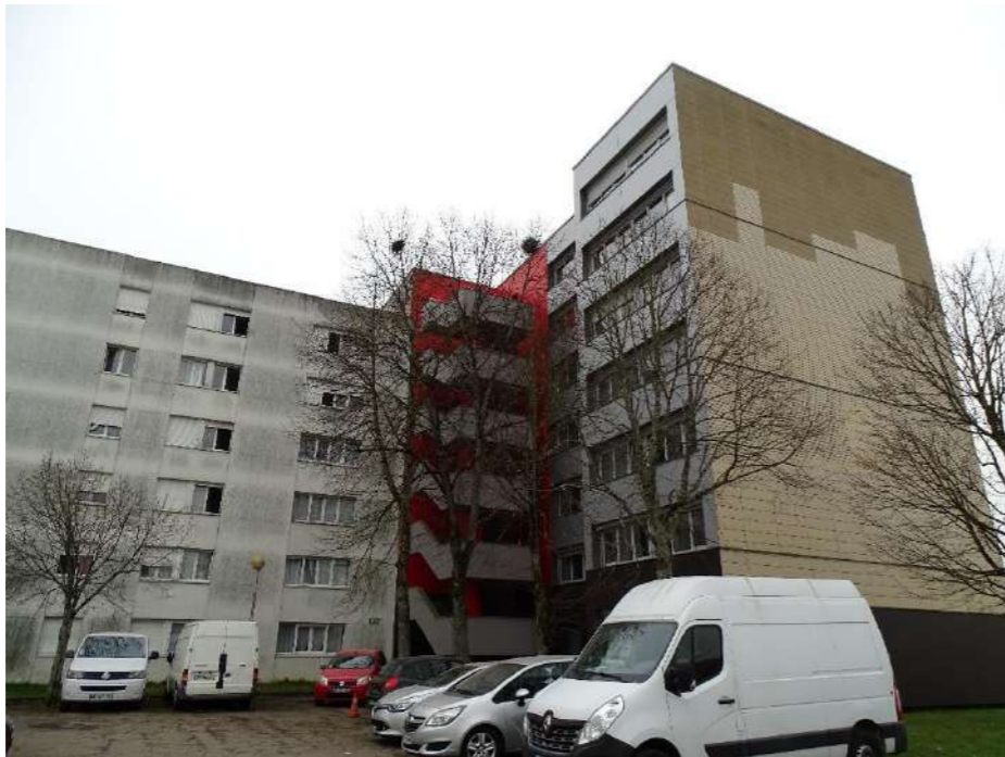
Immeubles d'habitations du quartier « La Haute Mazelle », au nord de Limoges
