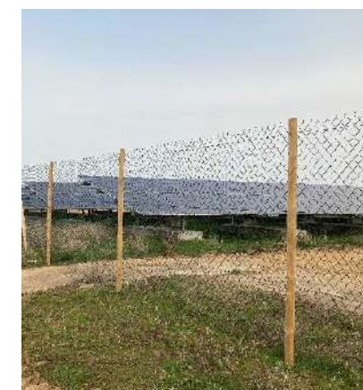
Exemple de clôture (source : urbasolar)
