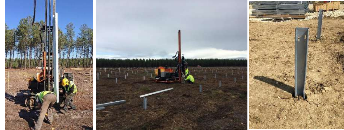
Exemple de pieux et de leur mise en place (URBASOLAR)
