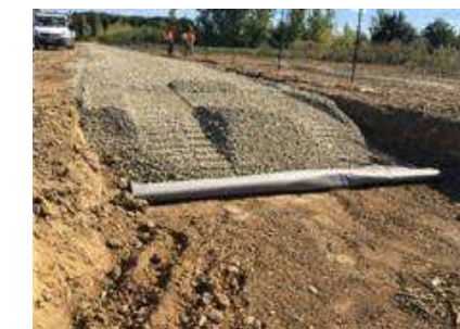
Exemple de réalisation de voie d'accès interne Source : Urbasolar
