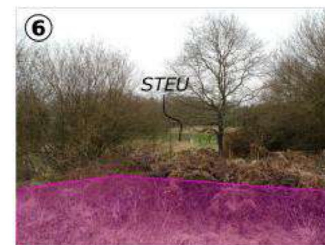
Vue sur la STEU de Chaptelat depuis le nord-ouest de la ZIP
