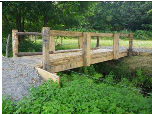
Exemple de réalisation d'une passerelle Source : SABV
