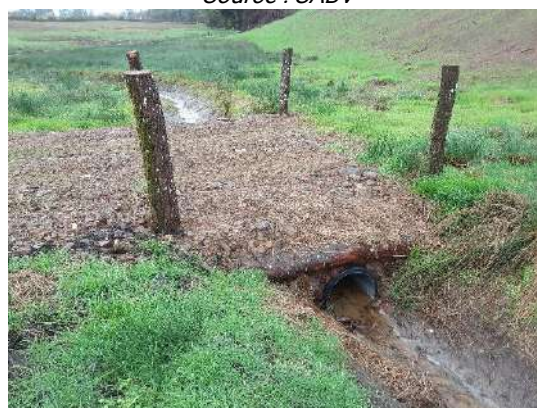
Exemple de réalisation d'un hydrotube Source : SABV
