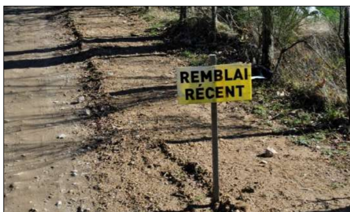
Photographie 43 : Exemple de remblai de tranchées électriques le long d'une piste (Source : ENCIS Environnement)
