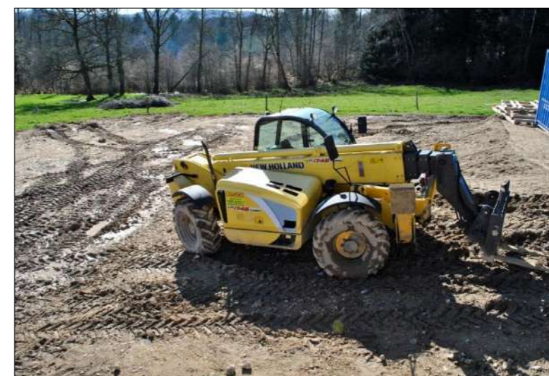
Photographie 42 : Exemple de tassement et d'ornières créés par les engins de chantier
