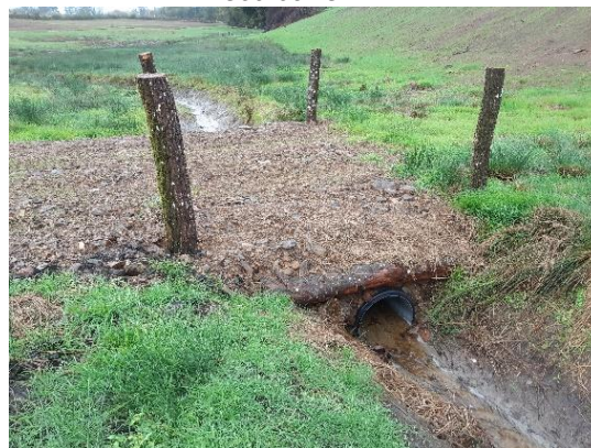
Exemple de réalisation d'un hydrotube Source : SABV
