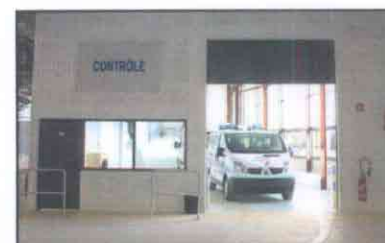
Chambre de contrôle avant livraison
