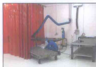
Poste de soudure de pièces métalliques
