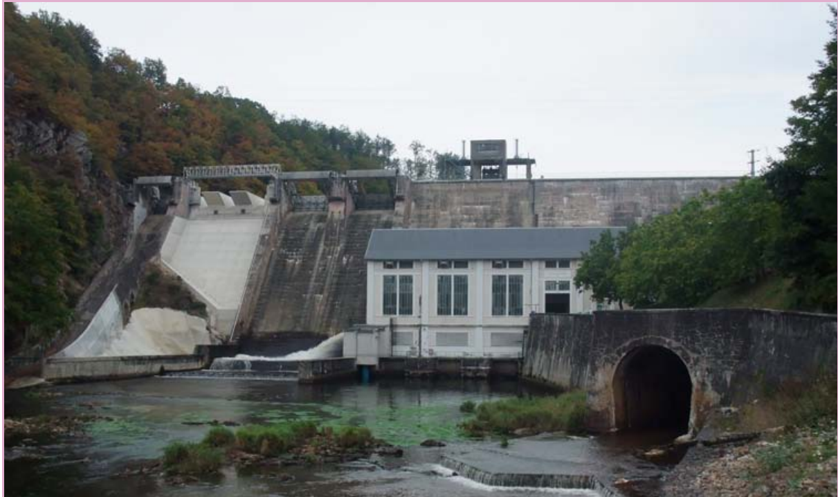
- Barrage de Saint-Marc à Saint-Martin-Terressus -
